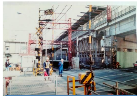
駅の高架工事 (平成元年)
