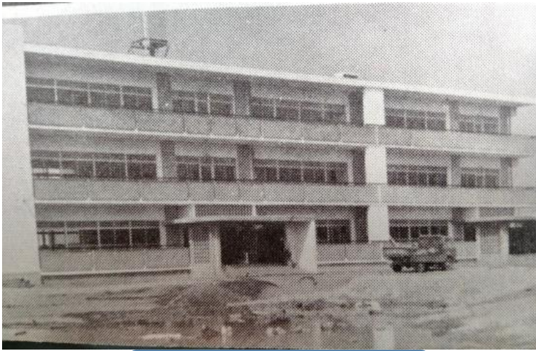
新校舎の建設現場
