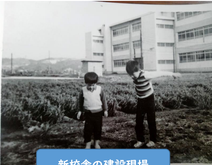
新校舎の建設現場
