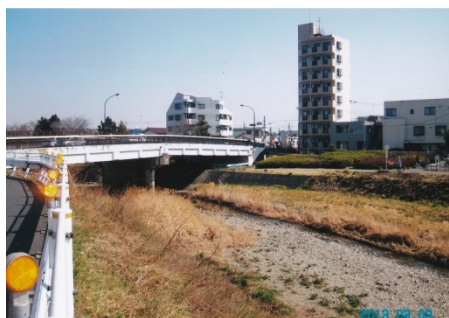
南浅川付近の水無瀬橋
