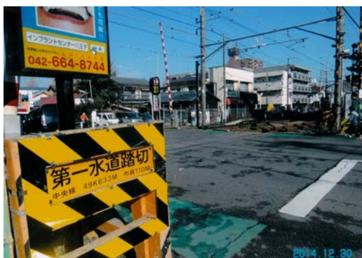
第一水道踏切
