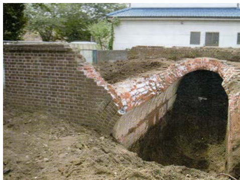
甲武鉄道建設時の煉瓦暗渠 平成 16 年撮影 (八王子郷土資料館)
