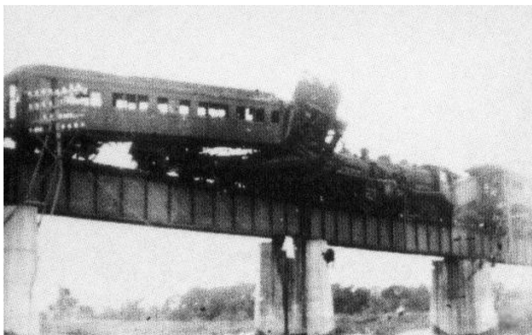
昭和 2 0 年国鉄八高線多摩川鉄橋列車衝突事故 (1945. 8. 24)
