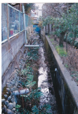
埋立地後の下水溝
