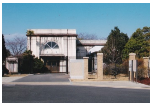
元本郷浄水場全景
