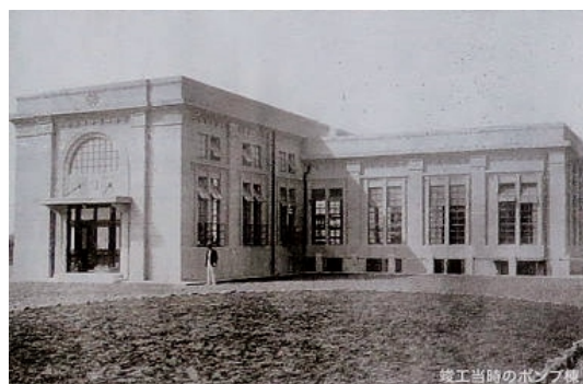
竣工当時のポンプ棟
