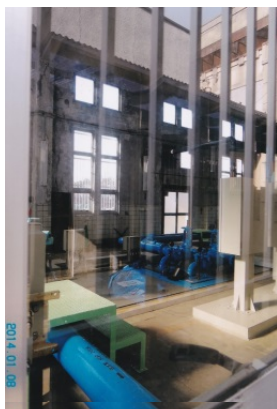
旧給水施設の内部
