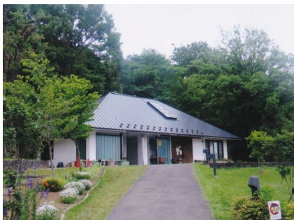
堀之内寺沢里山公団管理棟
