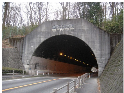
小田野トンネル 国道61号線
