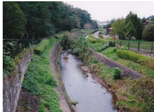
湯殿川（櫛橋より上流）
