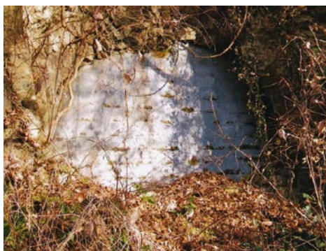
浅川地下壕西側 (今はコンクリートで塞がれている)
