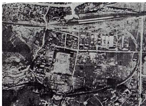
地下壕への引き込み線 昭和 21 年 3 月末米軍撮影 上部は浅川駅 (現、高尾駅)
