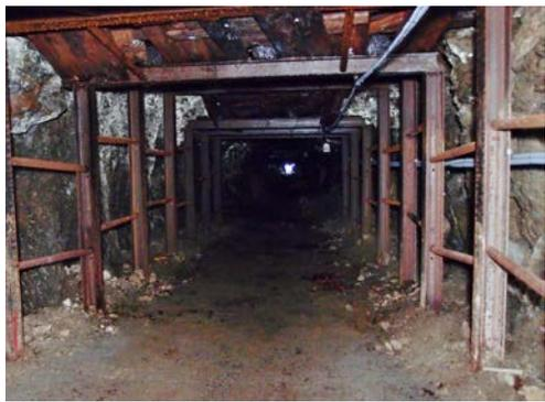
ダイナマイト搬出用に補強した鉄柱
