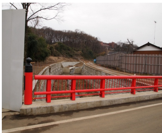
新しくなった湯殿川と西明神橋
